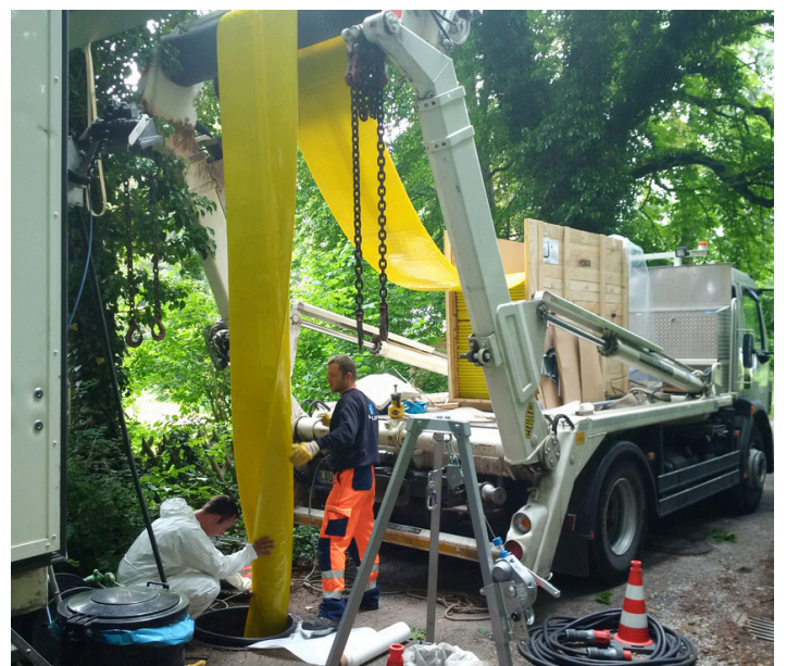
Einzug Schlauchliner in Kanal
