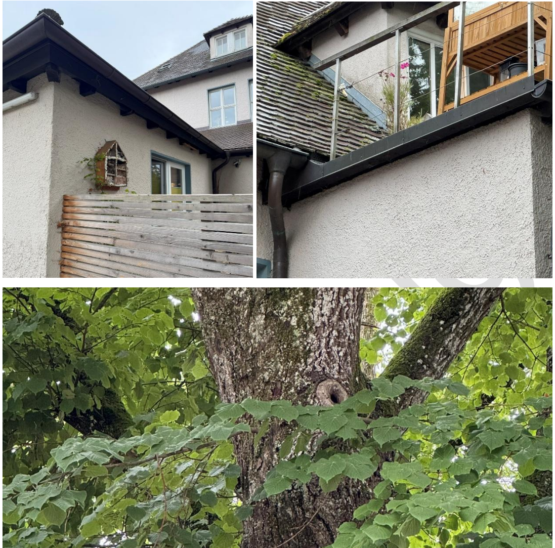
Abb. 5 Naturschutzfachliche Strukturen im Plangebiet - Insektenhotel (Bild 1), schmaler Abstand zwischen Wand und Dachhaut (Bild 2), Baumhöhle an ausgefalltem Astloch (Bild 3), (eigene Aufnahmen PV)
