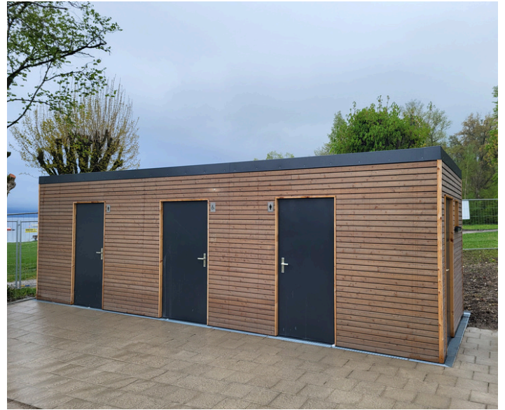
Die neue WC-Anlage mit Verkleidung aus sibirischer Lärche fügt sich harmonisch in das natürliche Ambiente des Summerparks ein.
