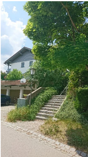
Abb. 2 Böschung an der Andechser Straße, PV eigene Aufnahme (06.2023)
