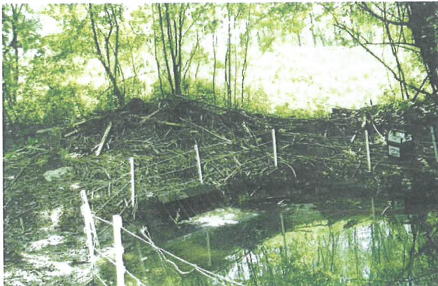
**Abb. 8. Elektrozaun zum Schutz eines Rohrdurchlasses vor Verbau durch Biber.**
