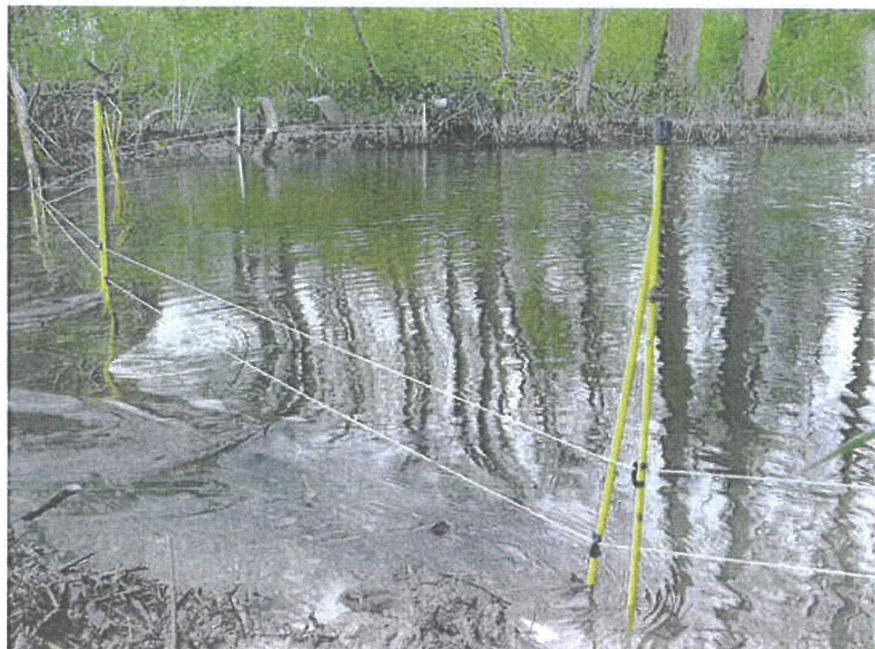
**Abb. 7.** Elektrozaun mit Glasfiberstäben über abgetragenem Biberdamm. Der Zaun wird an den Ufern ober- und unterhalb des Dammes 5-10 m weitergeführt (weiße Pfähle im Hintergrund).
