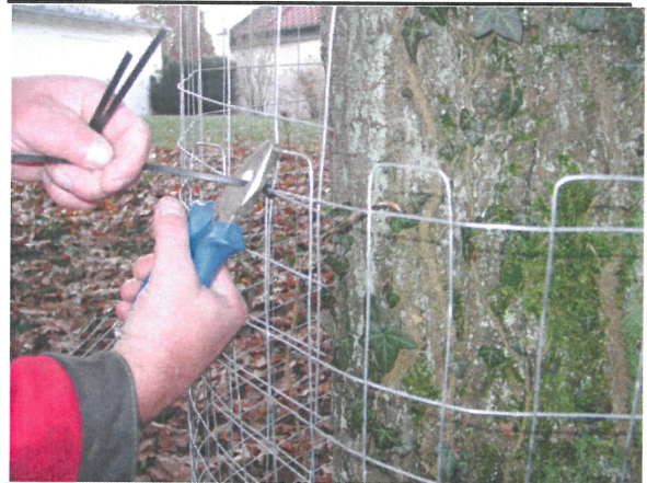
Abb. 6 Zuschneiden der Matten und Binder
